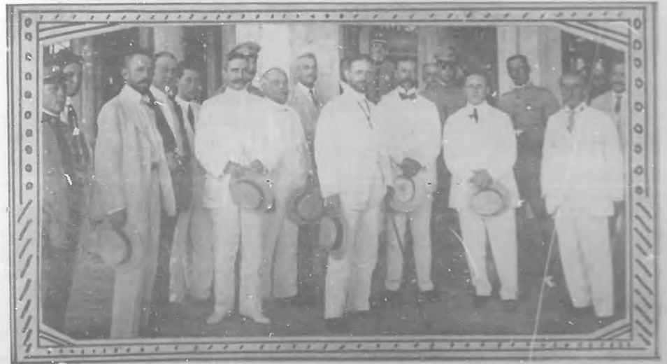
El general Mario G. Menocal, acompañado de los secretarios de Gobernación y Obras Públicas; el arquitecto Inspector del Estado señor Hilario del Castillo Avilés y demás personalidades durante la visita hecha á las obras del nuevo Palacio Presidencial. Foto de Félix.
